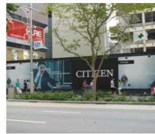
仮囲い広告 工事現場の仮設堀に掲出する広告物
